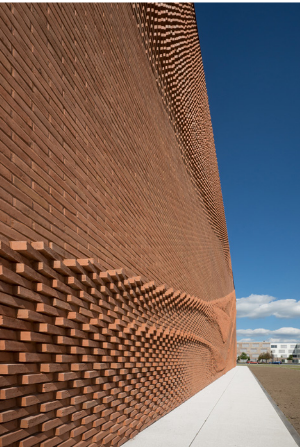
Fassade mit textiler Anmutung: Die differenzierten Tiefen der sechs speziell entwickelten und angefertigten Ziegelsteine reflektieren den Himmel völlig unterschiedlich und lassen ein ständig neues Spiel von Licht und Schatten entstehen.
